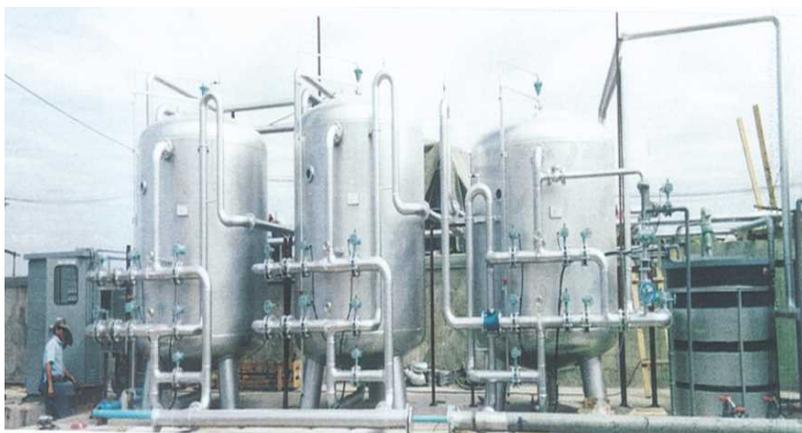
急速濾過装置＋軟水処理(河川水処理)
