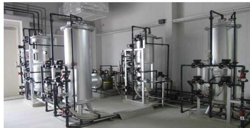
全自動活性炭ろ過装置 + 混床式純水装置
