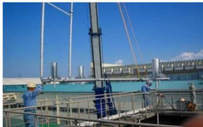
廃液を抜かずに取付・配管工事が可能
