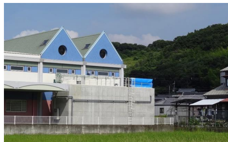
排水処理施設(食品工場)
