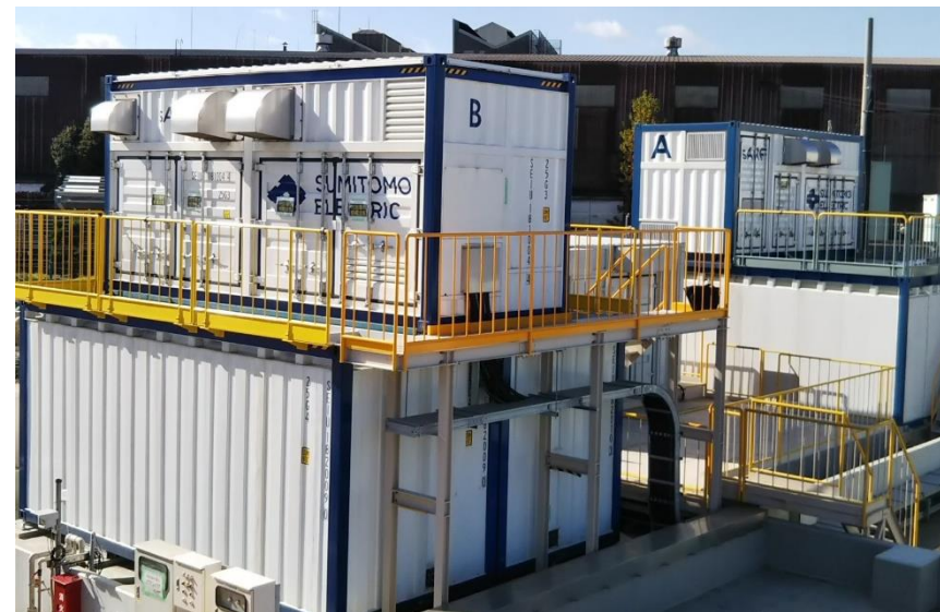
設置場所: 住友電気工業株式会社 大阪製作所 電池容量: 750kWh (250kW × 3h)
