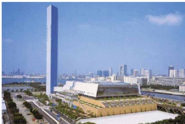
中央清掃工場(東京都中央区)
